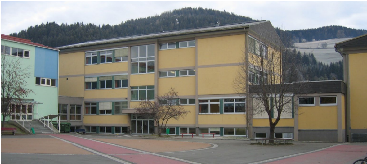
Abbildung 1 und 2: Gesamtansicht vor und nach der Sanierung:
